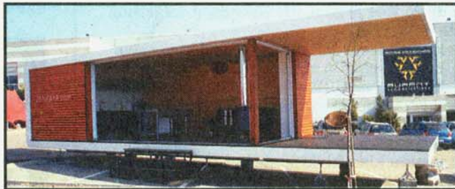
Die luukse losstaande eenheid word vooraf vervaardig. Die eienaar moet dit slegs aan elektrisiteit, water en 'n drein koppel.
